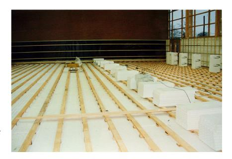
Mit der Warmwasser-Fußbodenheizung THERMOLUTZ System NE/TE-S konnt diese Forderung leicht erfüllt werden: Omegaförmige Wärmeleitbleche aus verzinktem Stahlblech umgeben das Kunststoff-Systemheizrohr umfangschlüssig und leiten die Wärme in die darüberliegende Abdeckung aus kunststoffbeschichtetem Stahlblech.
